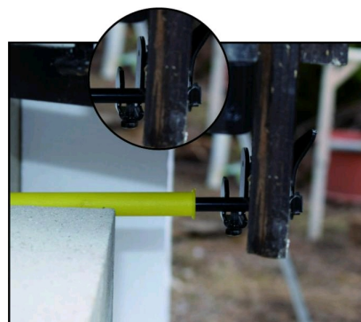
Installer la butée universelle : l'arrêt de volet ISO est mis en place !
